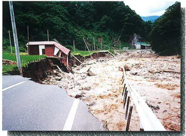
② 被災状況 (H7.7)
