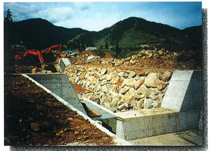
⑥ 復旧状況 (H8.9)
