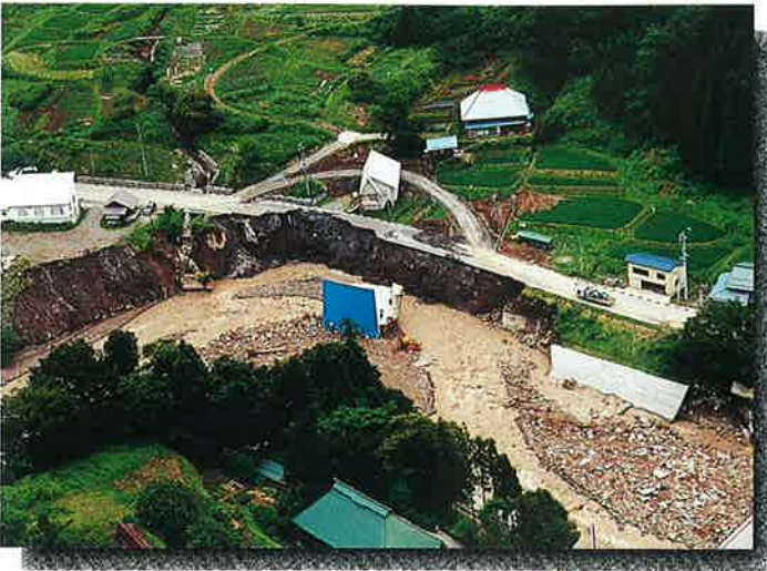
③ 被災状況 (H7.7)
