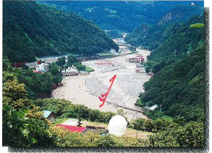
② 被災状況 (H7.7)
