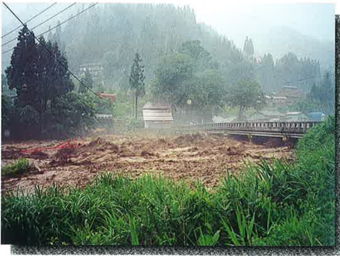
① 出水状況 (H7.7)
