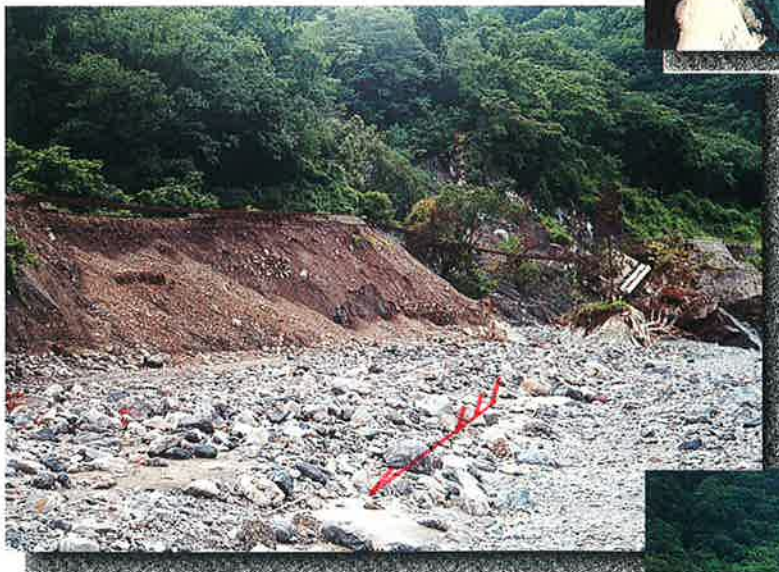
③被災状況 (H7.9)
