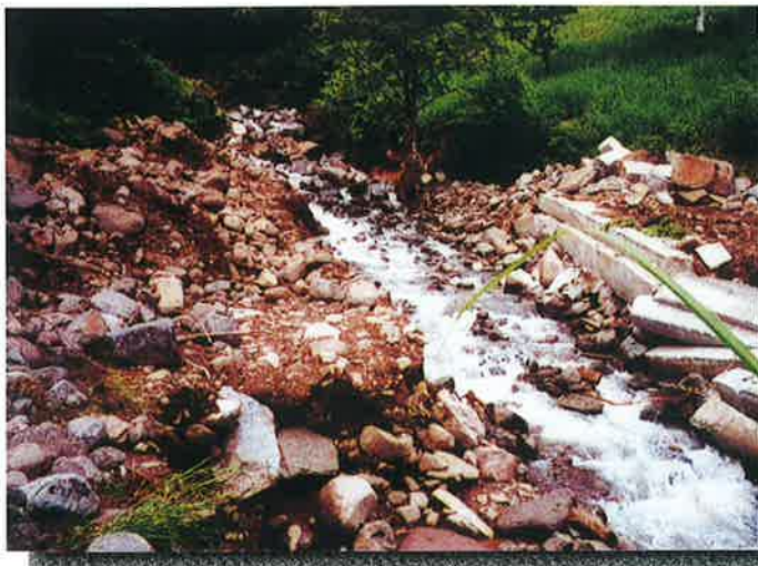
⑤ 被災状況 (H7.7)
