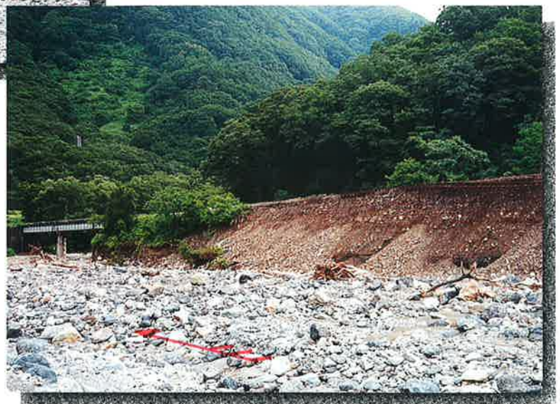
④被災状況 (H7.9)
