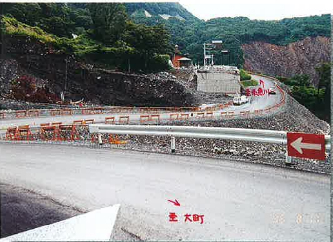
⑤仮復旧状況 (H7.8)
