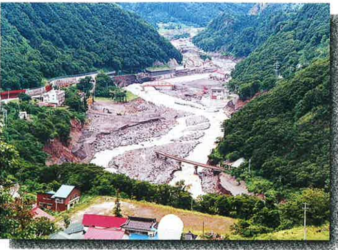
⑤ 被災状況 (H8.6)
