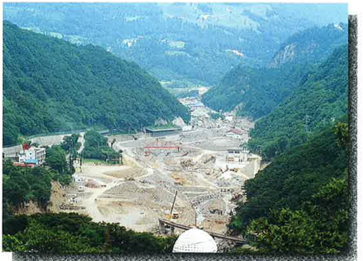
⑥ 復旧状況 (H8.9)
