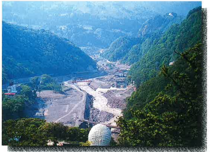
④ 復旧状況 (H8.5)
