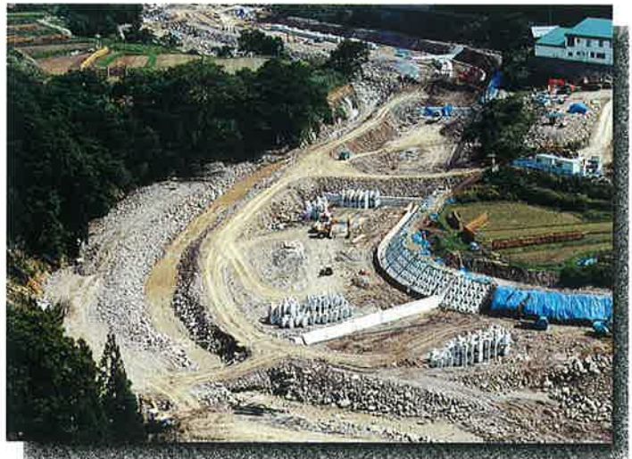
④ 復旧状況 (H8.9)
