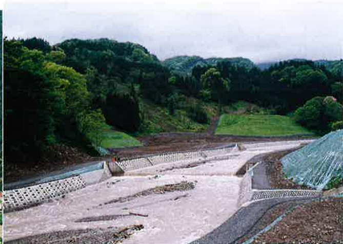
完成後の下流からの状況
