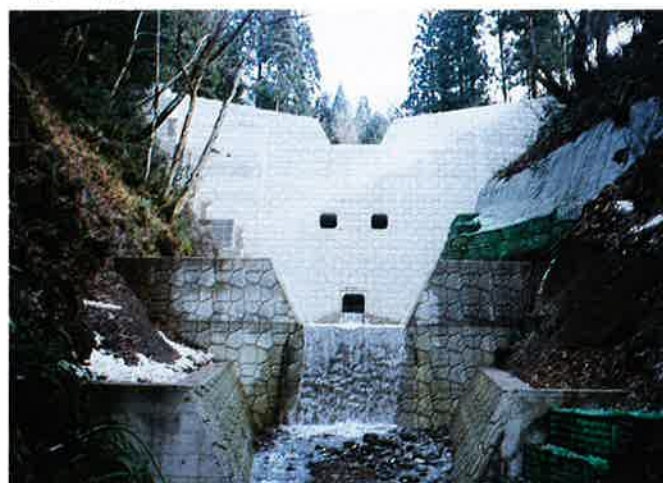
完成した砂防ダム
