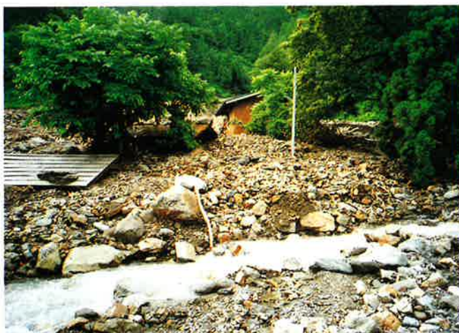
土石流により埋没した公民館
