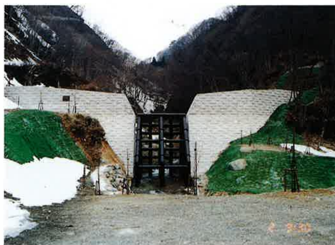
完成した鋼製格子砂防ダム
