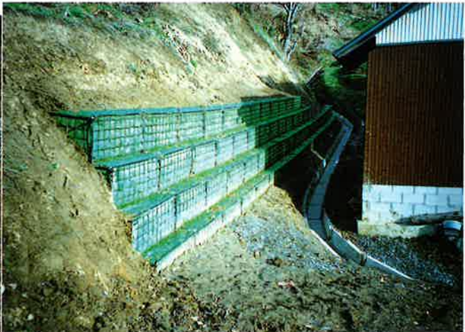
対策工が完成し人家が守られた
