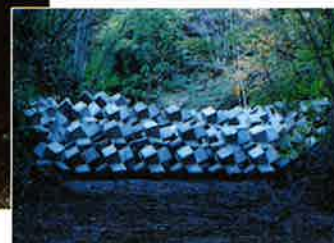
応急対策（コンクリートブロックダム）
