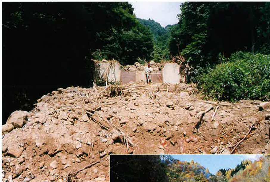
床固工を乗り越えた土石流
