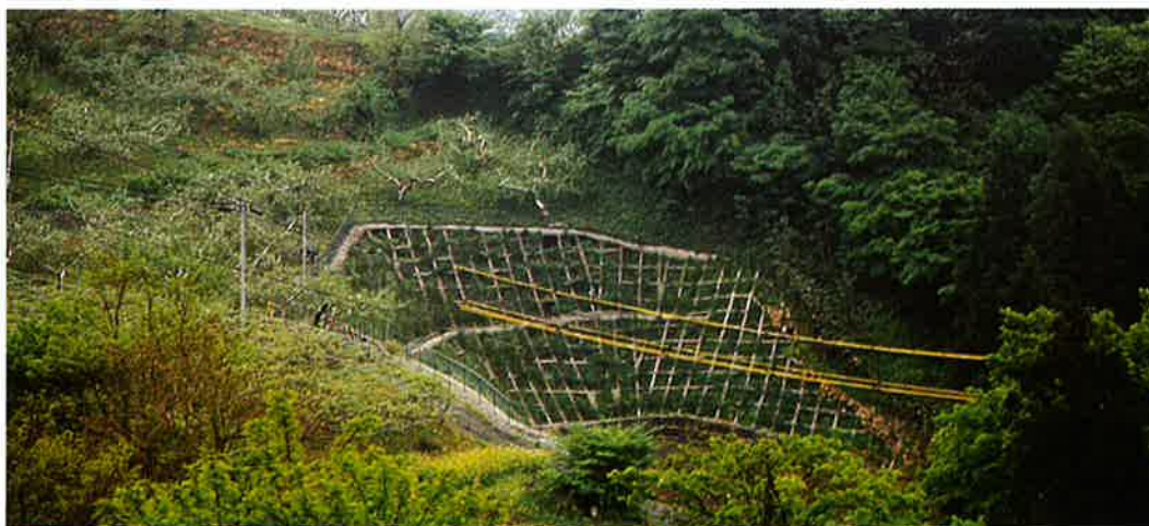
滑落部に施工された法枠工
