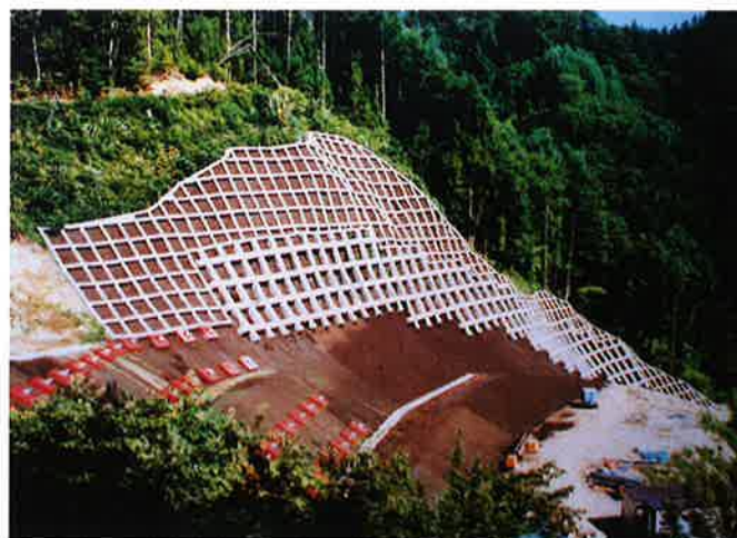
滑落崖に施工された法枠工
