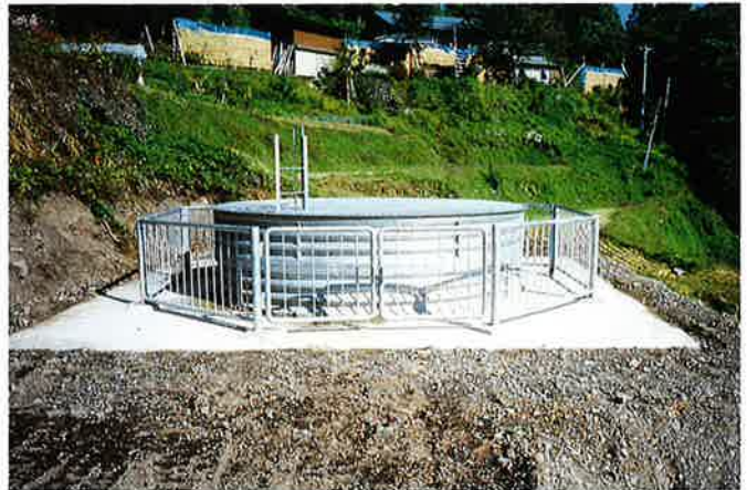
完成した集水井
