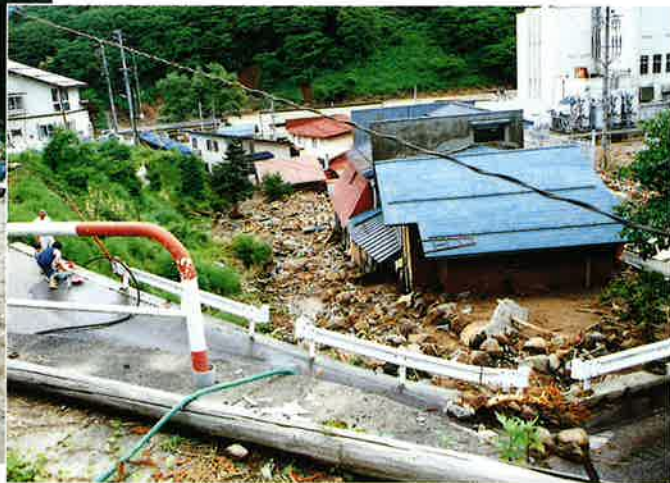
土石流により埋没した河道及び人家
