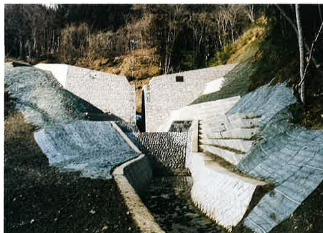
完成した砂防ダム
