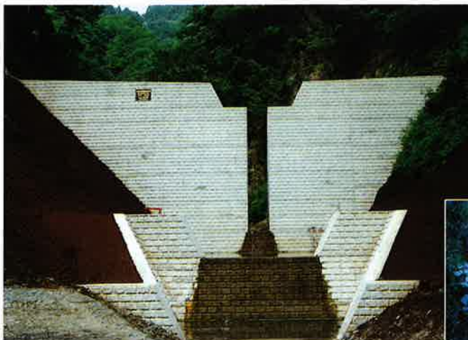
完成した砂防ダム
