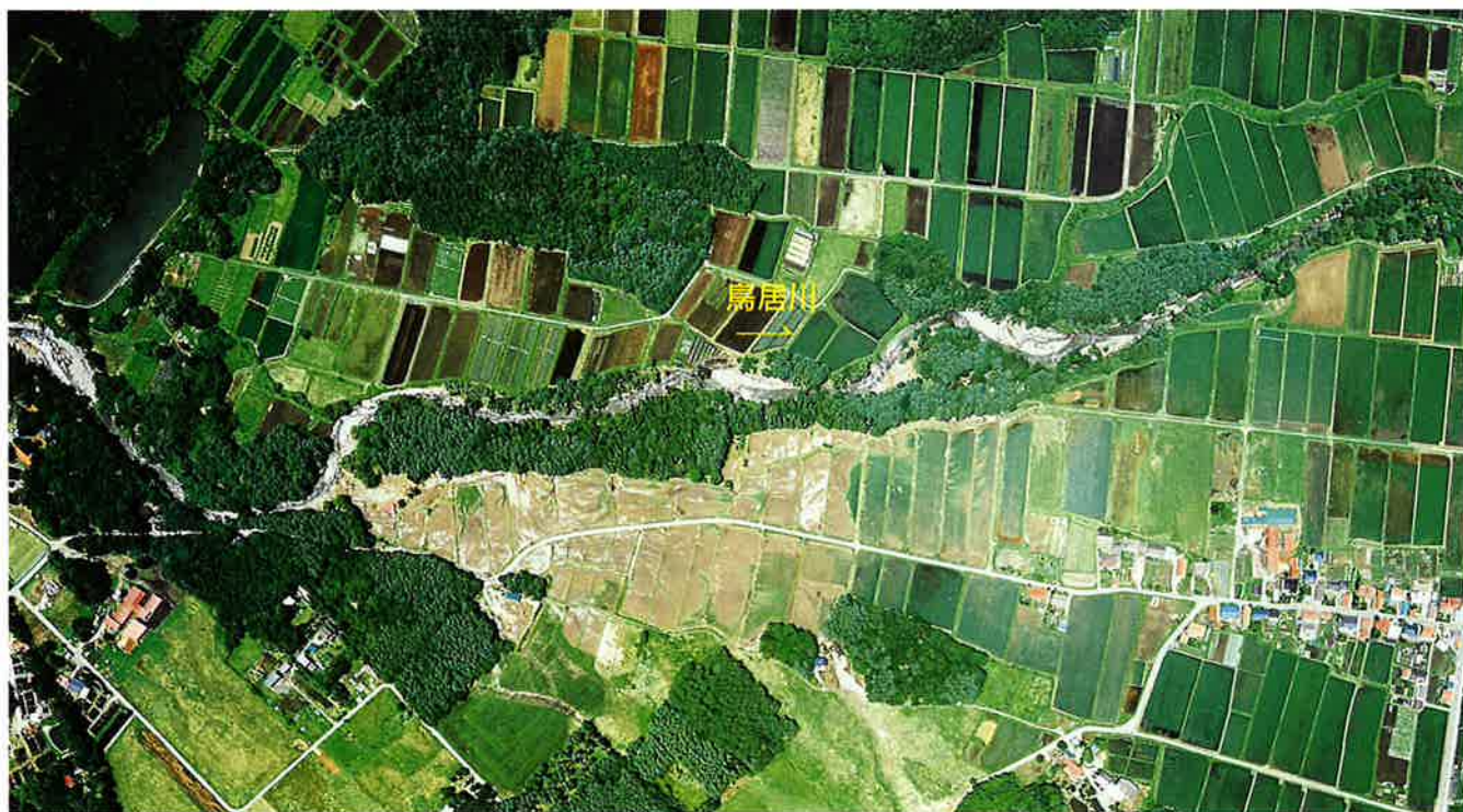
氾濫した鳥居川（信濃町）
