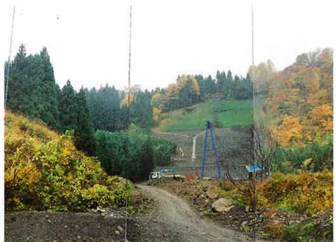
完成した頭部付近の状況
