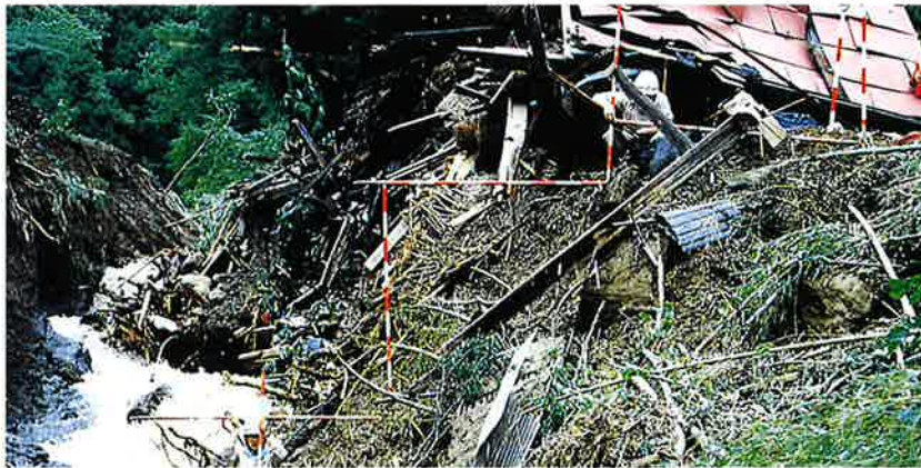
地すべりで倒壊した家屋と小川沢
