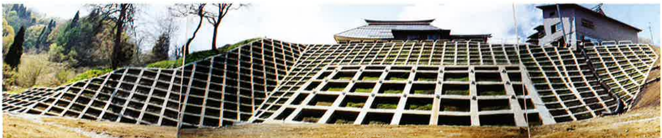
滑落崖に施工された法枠工
