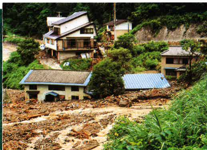
土石流により埋没した家屋
