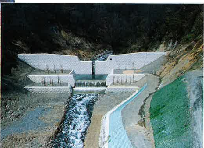
完成した砂防ダム
