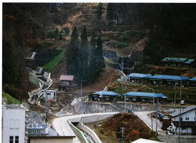
完成した2基の鋼製砂防ダム
