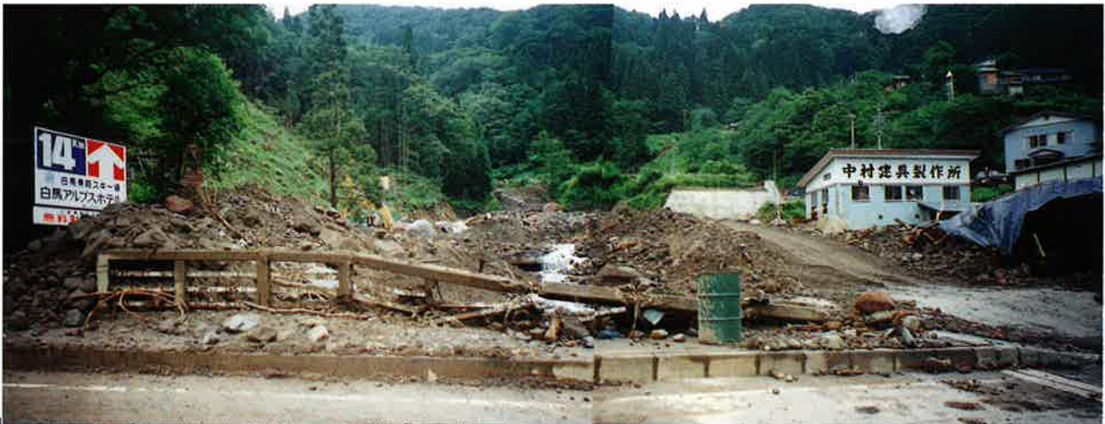
土石流状況（手前が国道148号）
