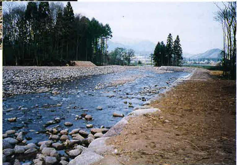
自然石を使用した護岸
