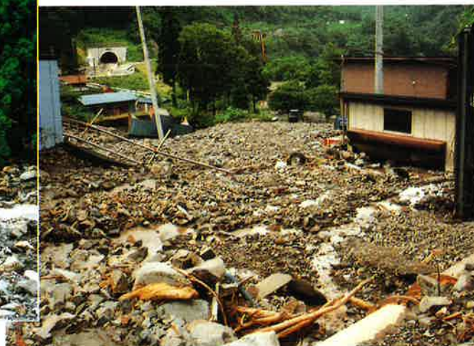
国道148号埋没状況
