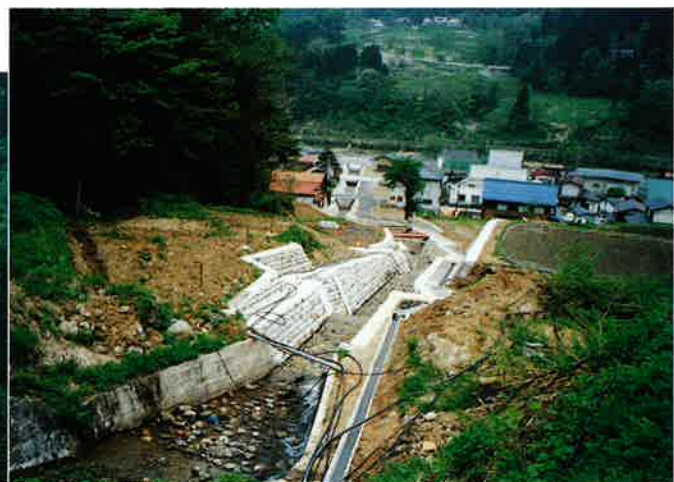
完成した護岸工（土石流流末処理）
