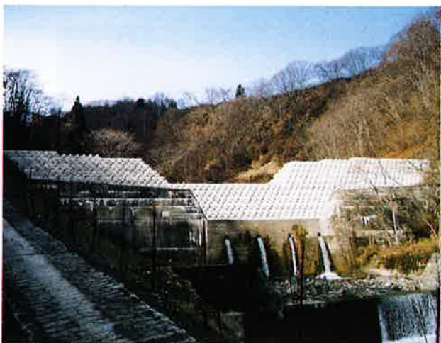
完成したコンクリートブロックダム
