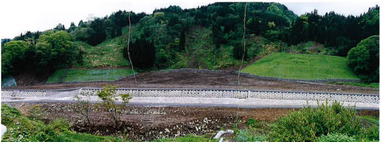
完成後の全景写真
