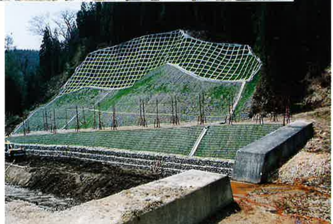
山腹工完成状況
