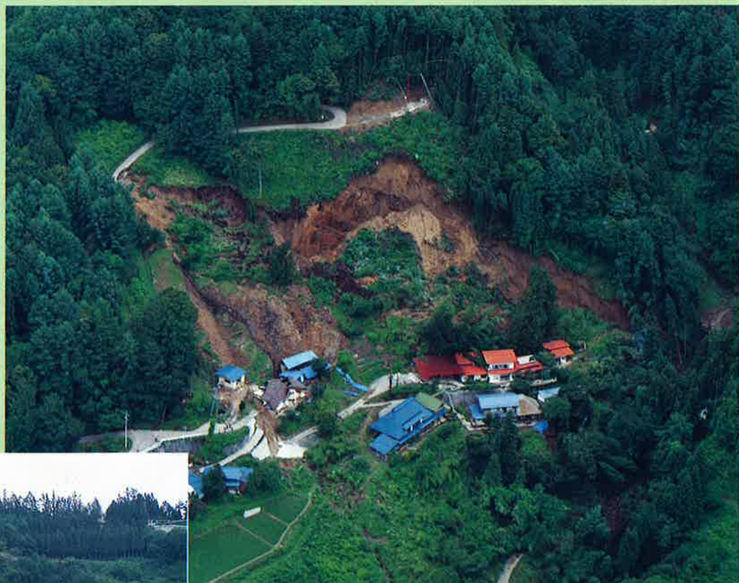
人家4戸が全壊した小川村中牧の地すべり
