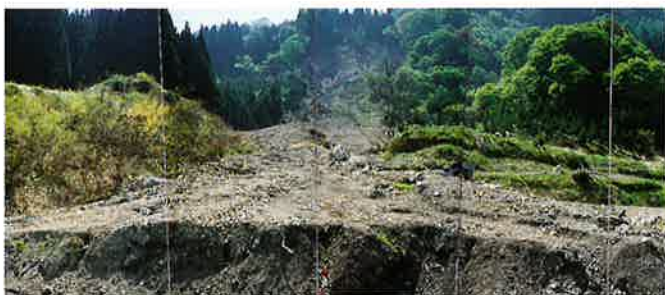
崩積土が厚く堆積している様子
