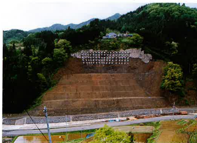
アンカー工、排土工完成後の全景写真
