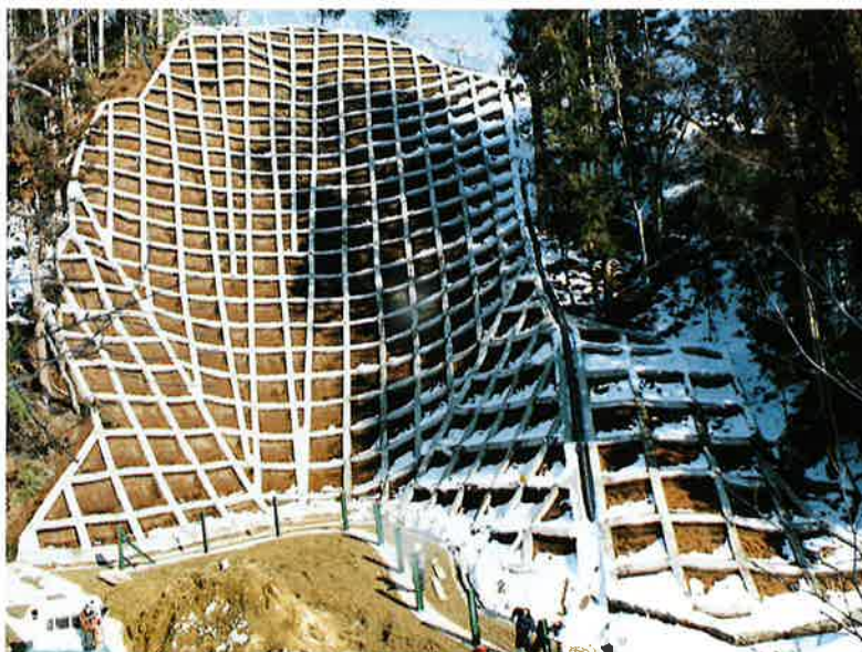
完成した、ロックボルト併用法砕工
