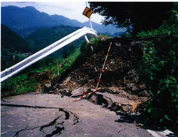
寸断された頭部付近の県道
