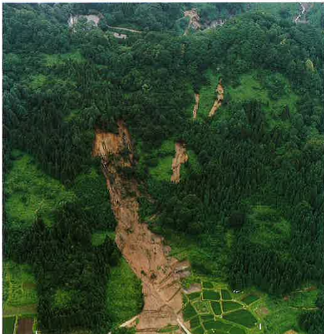
泥流化し下流に押寄せる地すべり土塊
