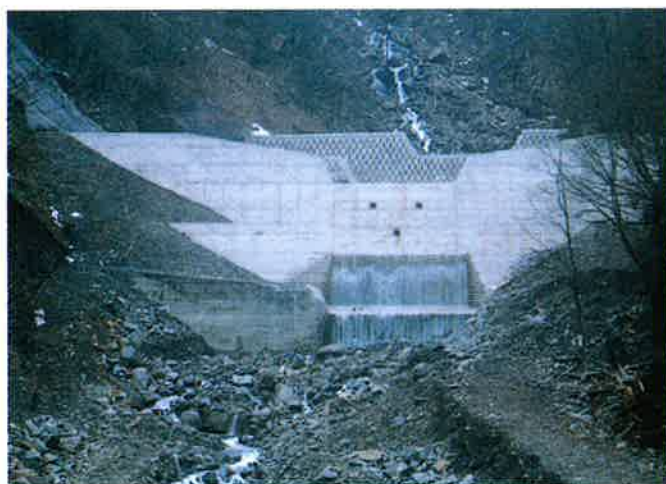
完成した下流ダム工
