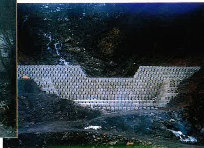
応急対策を兼ねたコンクリートブロックダム
