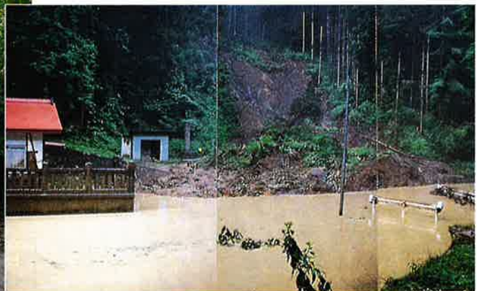
野間地すべりによる上流湛水域（左が小川神社）
