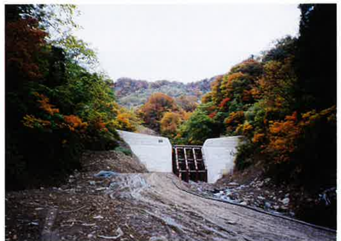
完成した鋼製格子ダム
