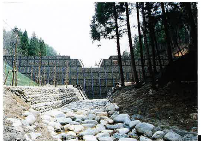
完成した砂防ダム
