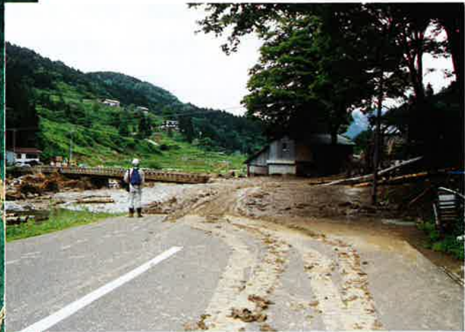
流出土砂により県道通行止
