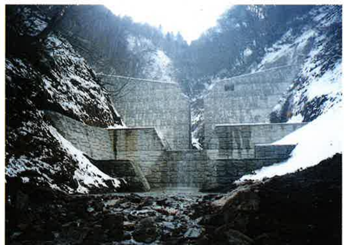
完成した砂防ダム
