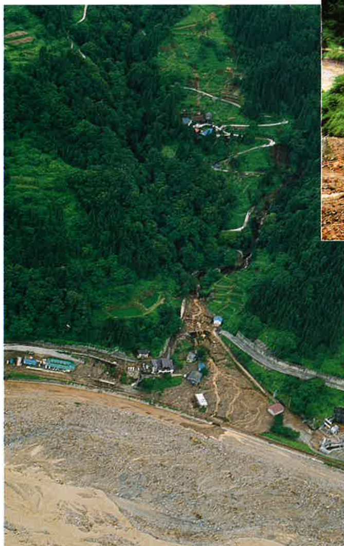
土石流状況（手前左端がJR北小谷駅）
