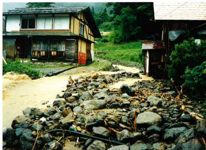
河道埋塞により氾濫した状況
