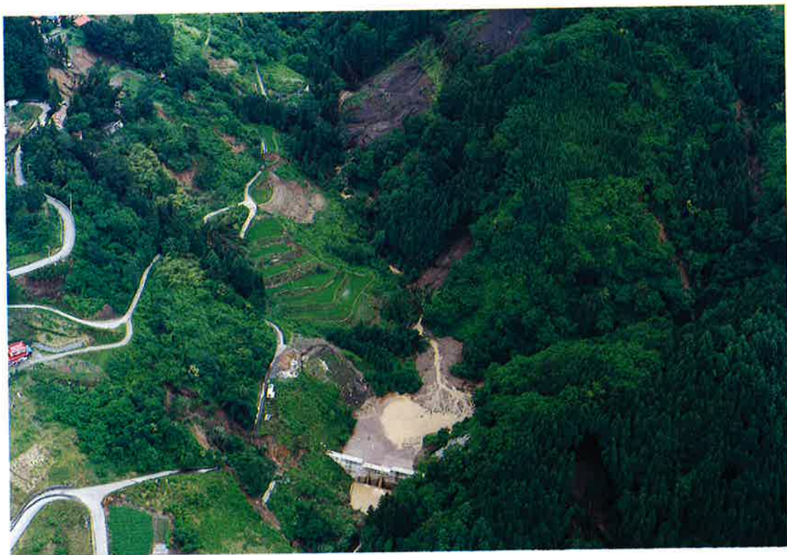
砂防ダムが地すべり被害を最小限におさえ下流を土石流から守る（小川村北尾沢）
