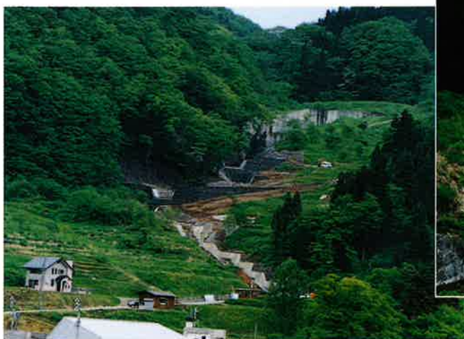
完成した2基の鋼製砂防ダム
