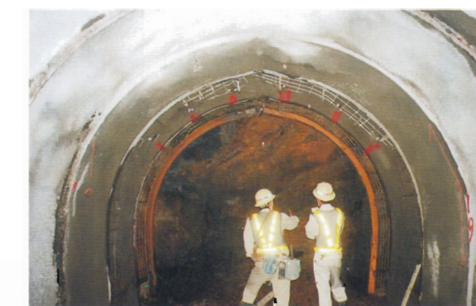
トンネル切羽状況
