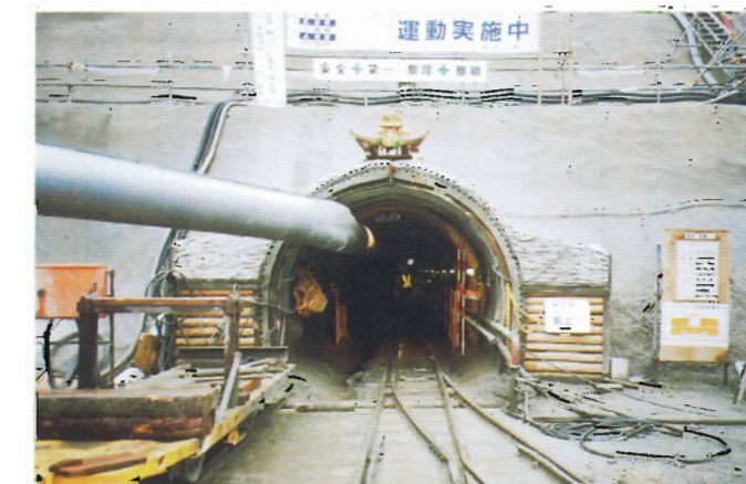
倉下排水トンネル工抗口
