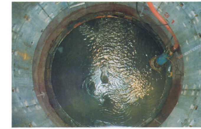
集水井掘削状況
