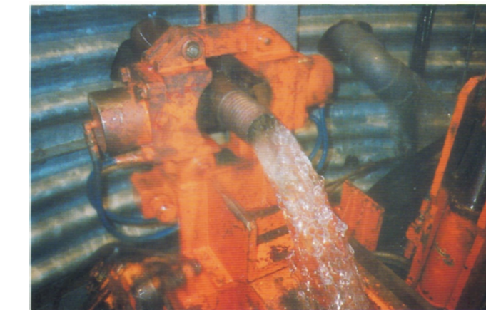
集水ボーリング掘削中の排水 (400ℓ/min)
