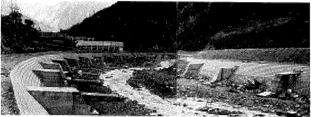
鹿塩川しゅん功 (歯型工施工区間)
