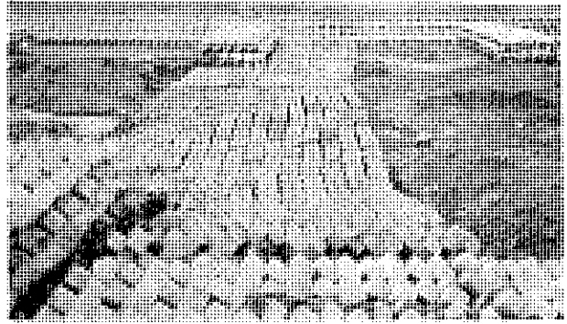
六脚ブロックによる床固工
