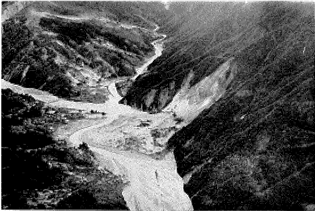
大西山崩壊状況(下伊那郡大鹿村大河原)
