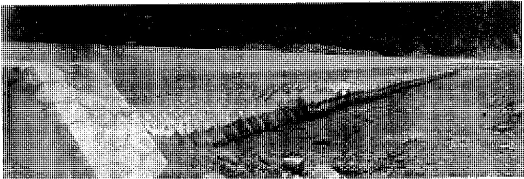
小波川上流左岸護岸及び根固しゆん功写真
