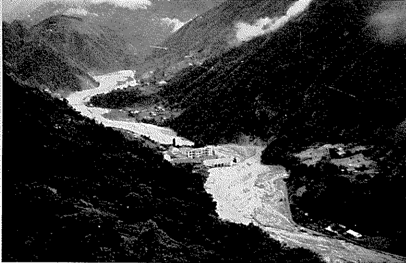
鹿塩川被災状況 (大鹿村鹿塩附近)
