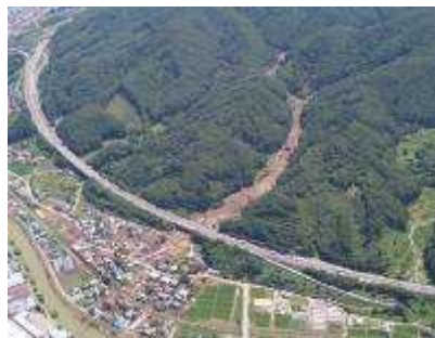
H18年豪雨災害（岡谷市）
