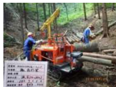
搬出作業状況
