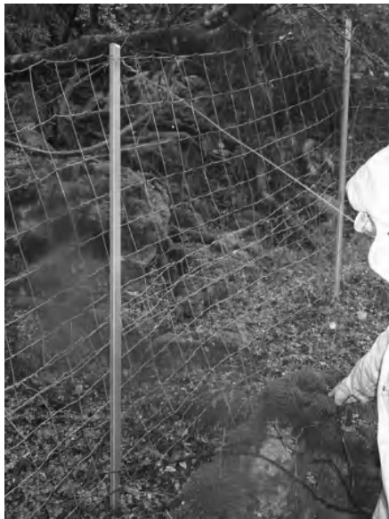
写真 6-1 柵外にある岩から侵入した事例
