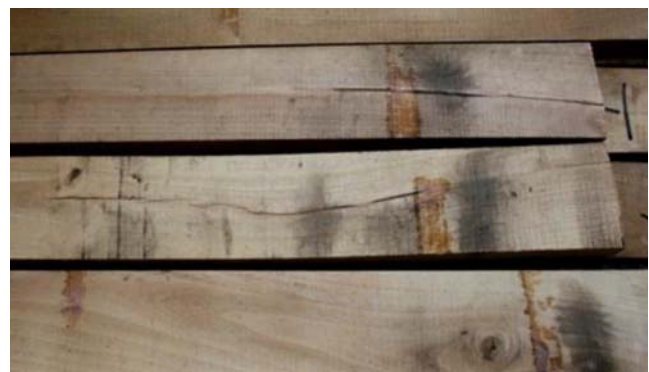
図-3 材面割れ(髓割れ)
