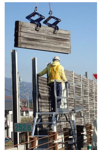
写真-1 遮音板交換 (H27.12.7)
