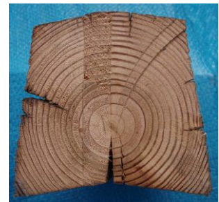
写真-2 カラマツ製遮音板 部材断面 (30年経過時)
