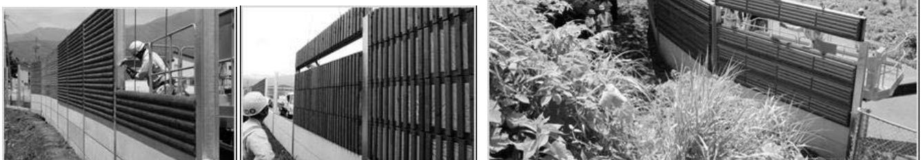
写真 中央自動車道 伊那 I C ランプ部への試験施工 (左から仕様K・E、T、Y の順)
