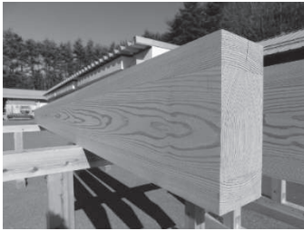
写真3 接着重ね梁Cタイプ
