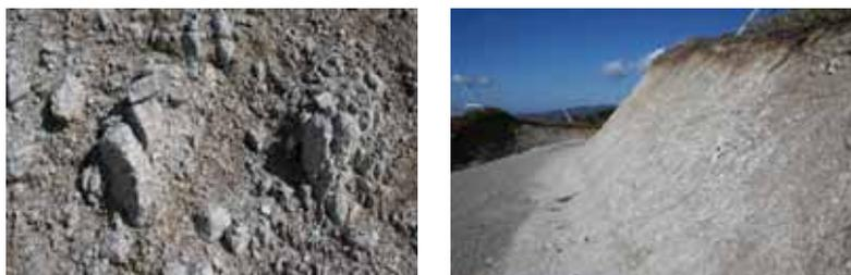
写真 5-4 強風化花崗岩と切取高を抑制した法面
