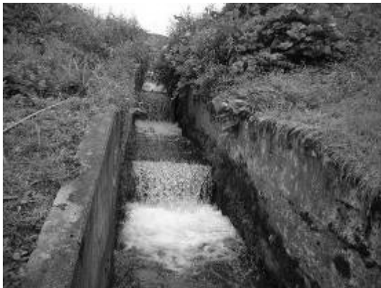
水車を設置する落差工の状況。
