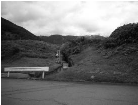
○実証試験設備設置予定場所概要 設置場所全景を示す。
