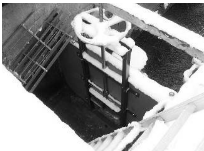
図 4-5 ゲート設置状況
