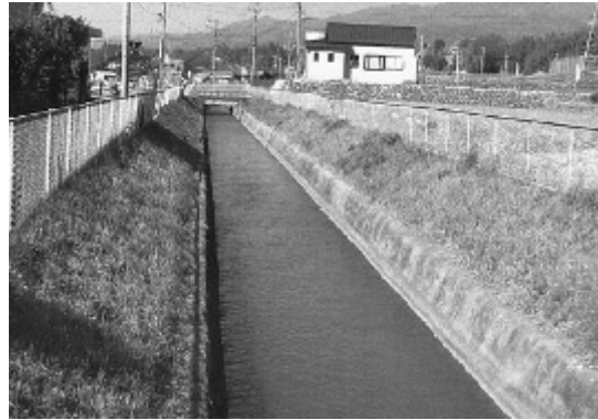
長野県竜西土地改良区 5.0[m 3 /s], 0.2[m], 0.6[kW]
