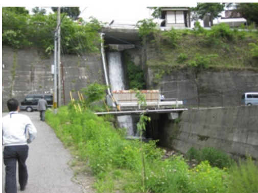
下流部から全体を撮影
