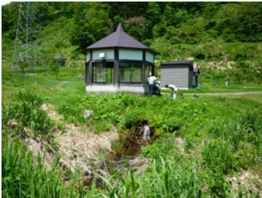
下流部から全体を撮影
