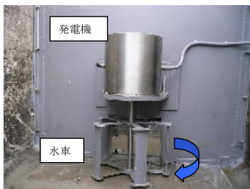
ダリウス水車外観（下流より）
