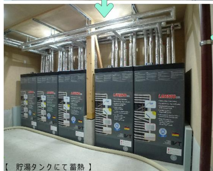
熱エネルギーとして貯める I V T社製（ドイツ）：ラテント蓄熱タンク 500L / 台
