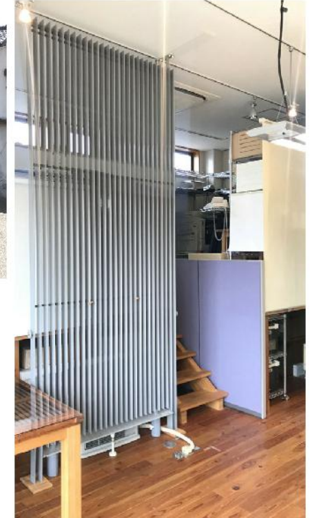
パネルヒータより 輻射熱全館暖房 及び 全ての給湯を賄う
