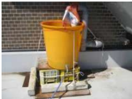
廃材を利用した雨水タンク
