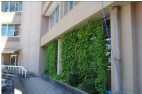
屋上から散水ホース
