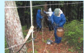
【防護柵の設置】
