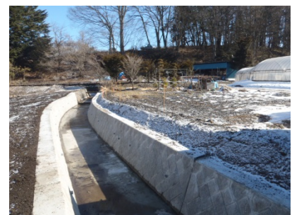
【完成した滝之湯堰】
