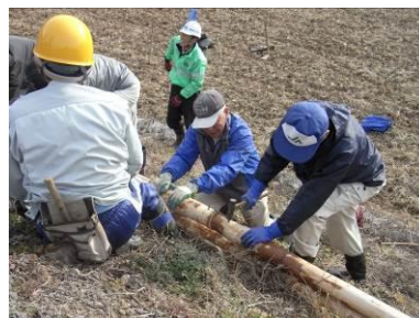
(畦畔法面への小段設置)
