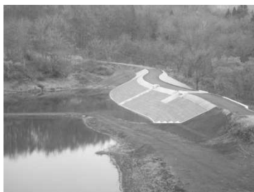
【堤体の改修によるため池の保全 （飯山市岡山地区下境新堤ため池）】
