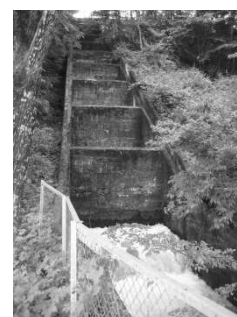
【春富地区 小水力発電施設建設工事箇所】
