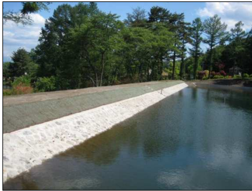
【堤体の改修により安全性が向上したため池】 (県営ため池等整備事業 駒ヶ根地区)
