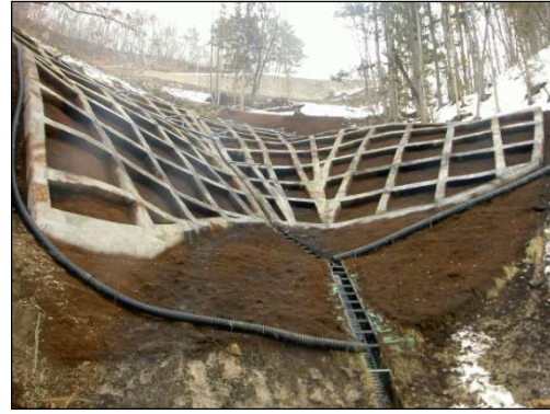
【法枠工等の整備により地すべりを未然に防止】 (地すべり対策事業 長岩地区)
