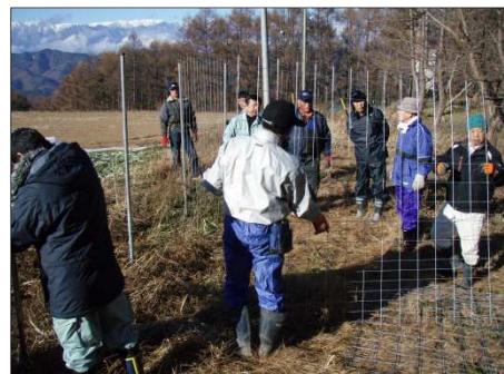
【集落住民による侵入防止柵の設置】
