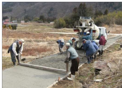
【向上活動：農道のコンクリート舗装】
