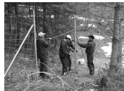
【集落住民による侵入防止柵の設置】
