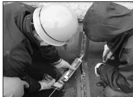
【資源向上活動：水路の目地補修】
