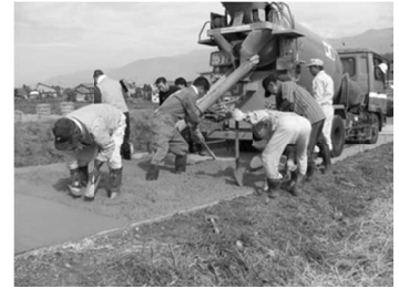
【集落共同による農道舗装作業】
