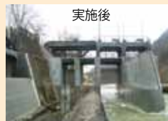
【長寿命化のための機械設備の更新、コンクリート補修を実施】
