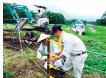
【電気柵の設置】
