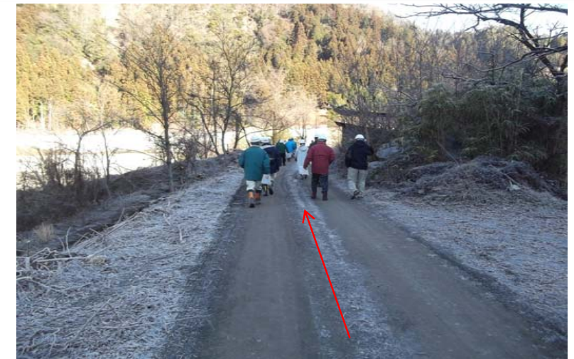
工事用進入路(堤防道路)
