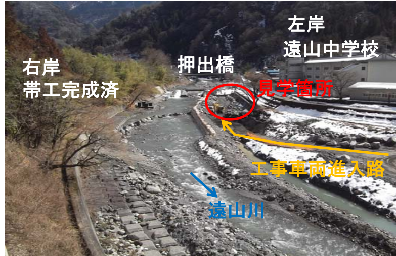
工事施工箇所全景
