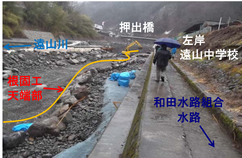
根固工見学状況(下流より)
