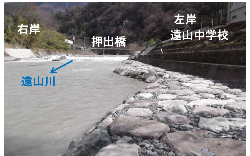
工事完成(根固工)
