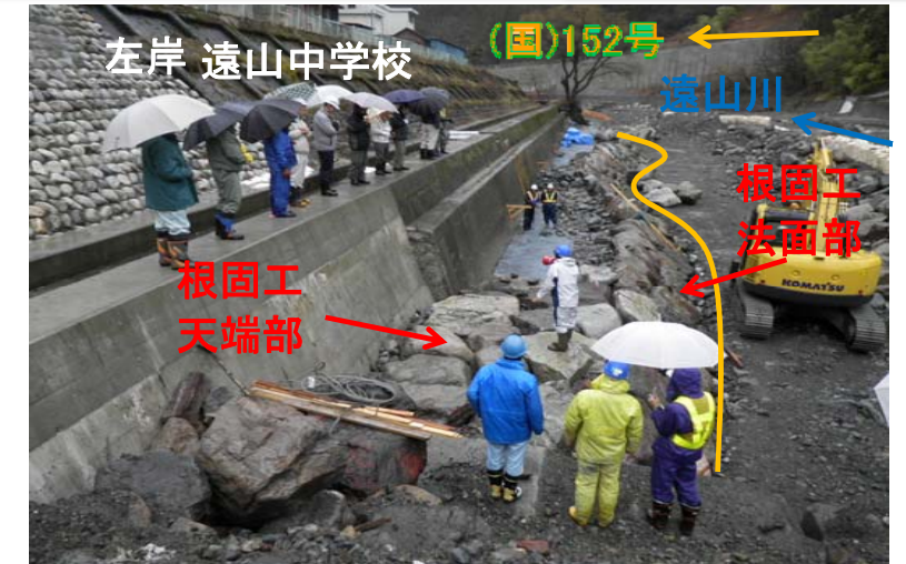
根固工見学状況(上流より)
