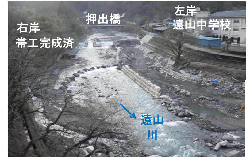
施工状況(3月17日)
