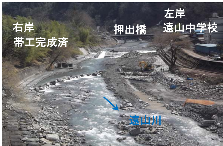
施工状況(3月24日)
