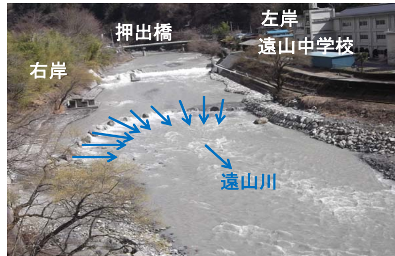
工事完成(全景)
