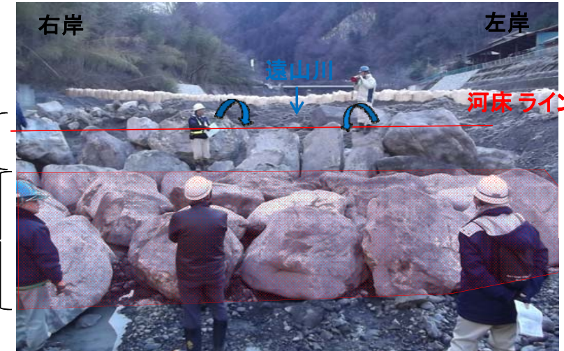
説明状況(帯工+床張工)
