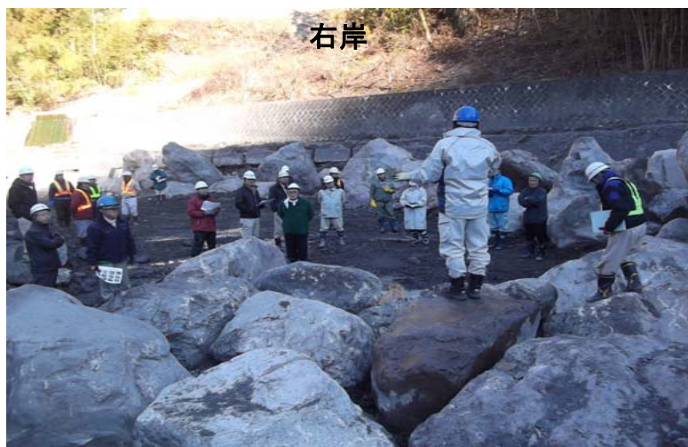
説明状況(帯工+床張工)
