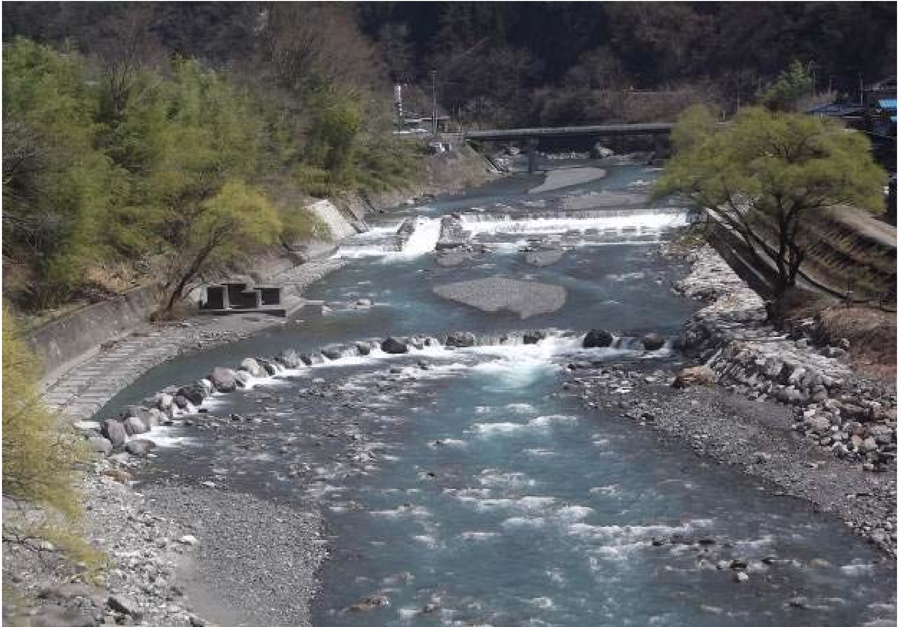
中学校横 工事完成後(平成26年4月9日)
