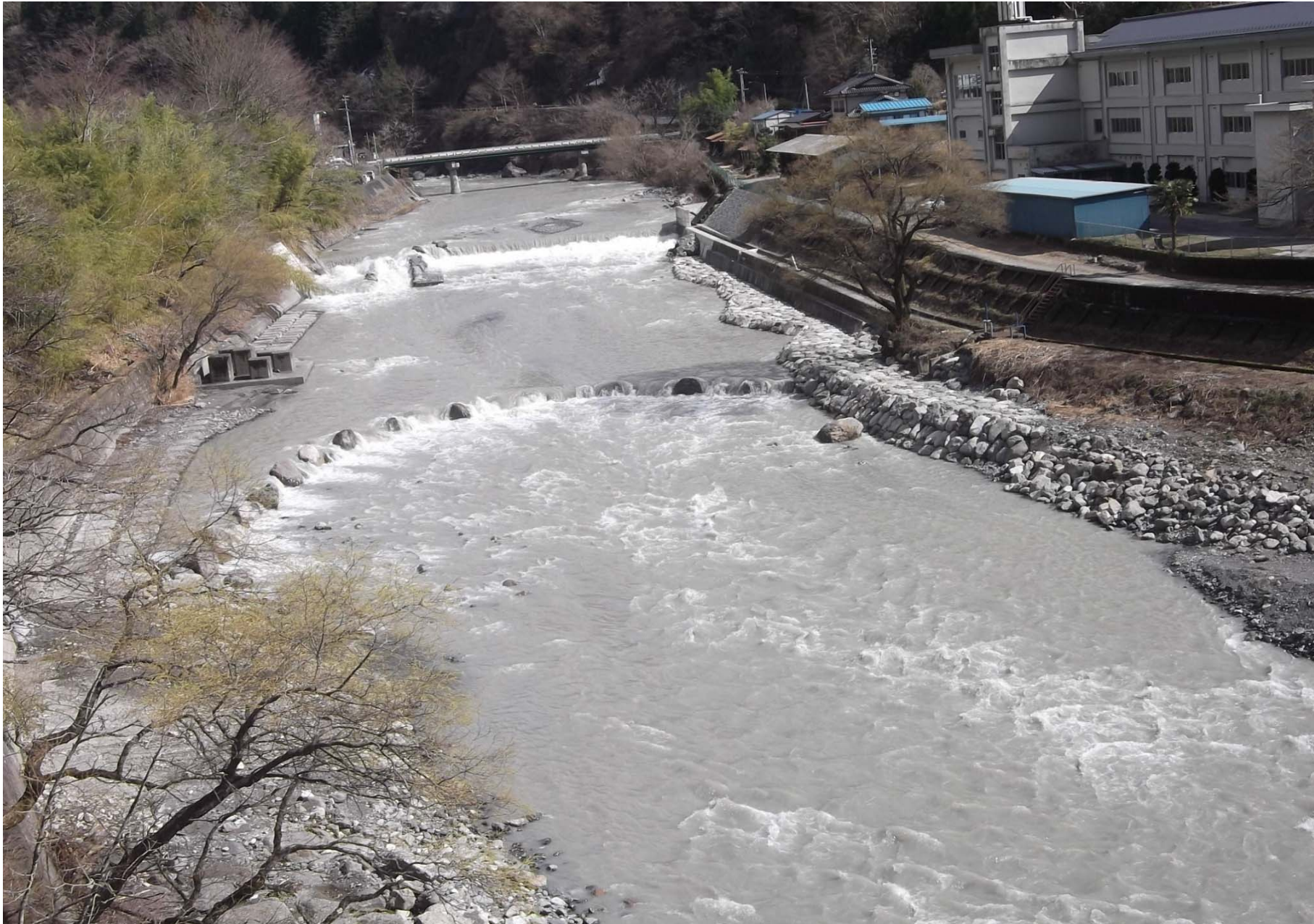
中学校横 工事完成(平成26年3月27日)
