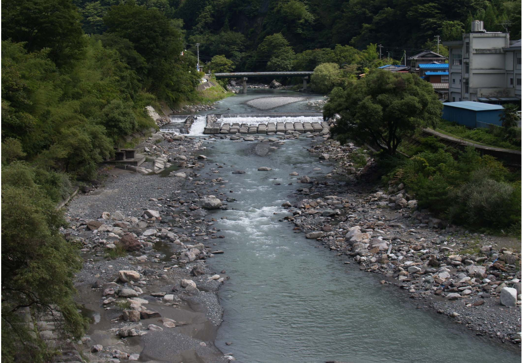
中学校横 工事着手前の状況
