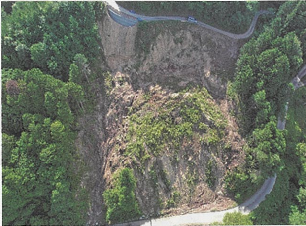
災害直後の崩落状況
