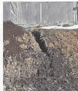
排水口から水が出ている状況
