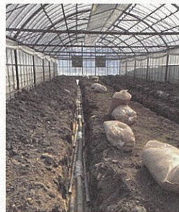
竹暗渠の敷設状況
