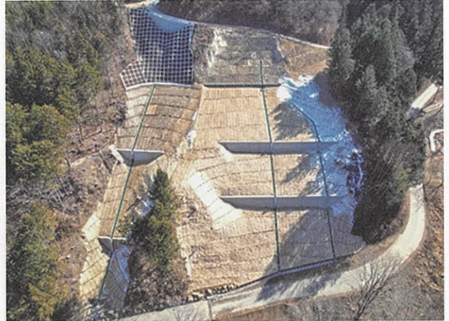
復旧工事が完成した後の状況
