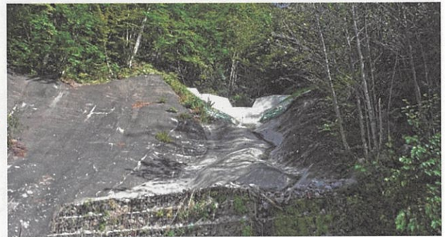
復旧工事が完成した後の状況
