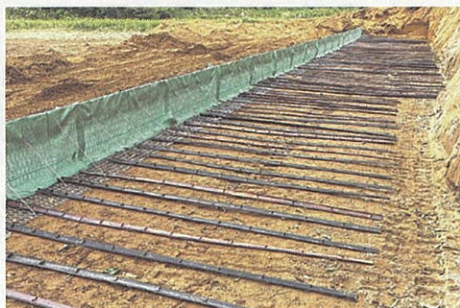
竹補強材設置イメージ
