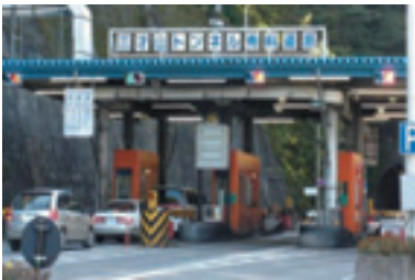
三才山トンネル有料道路（料金所）
