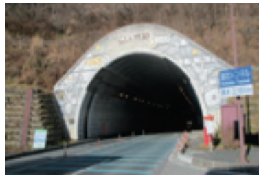
新和田トンネル有料道路（湖北トンネル）
