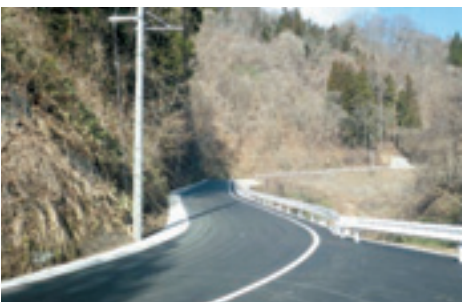
市道 中川手線 長野市 土口
