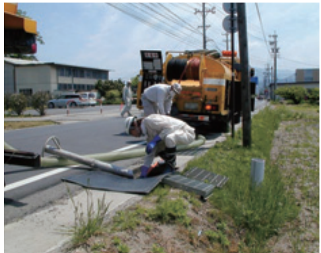
〔側溝清掃状況〕
