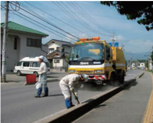
〔路面清掃状況〕
