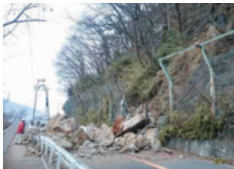
平成29年1月 岩盤崩落 (国)361号 伊那市 西高遠
