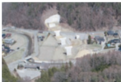
(国) 153号 伊那市 野底高架橋 施工状況
