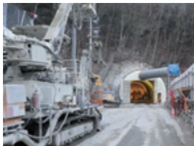
(一) 上松南木曾線 上松町～大桑村 和村トンネル 施工状況
