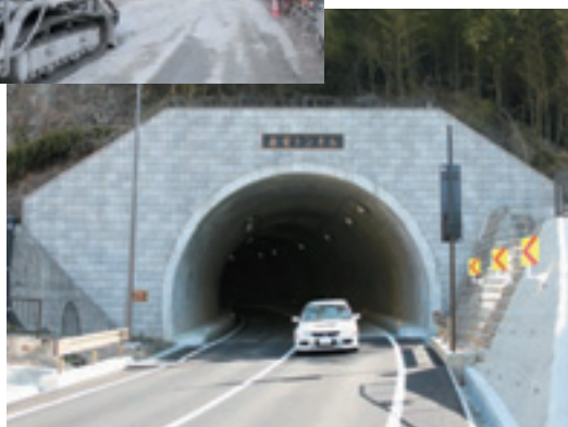
(主) 飯田富山佐久間線 泰阜村～阿南町 南宮トンネル
