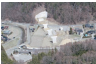
(国) 153号 伊那市 野底高架橋 施工状況
