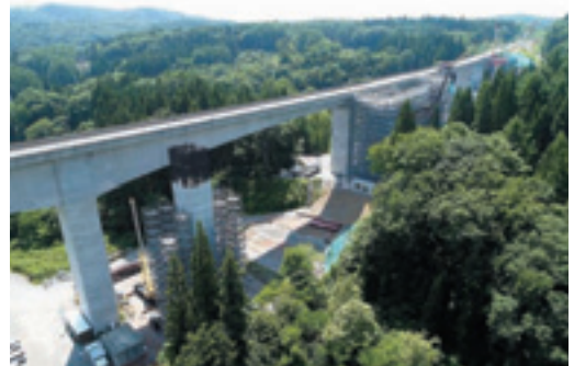
信濃町～妙高市 れいめい橋
