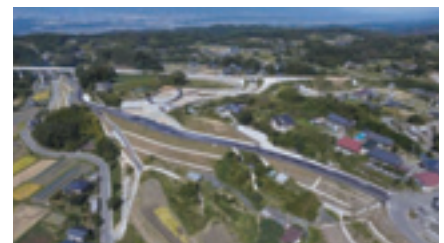
(国)256号 飯田市上久堅 拡幅 (平成29年9月29日供用)
