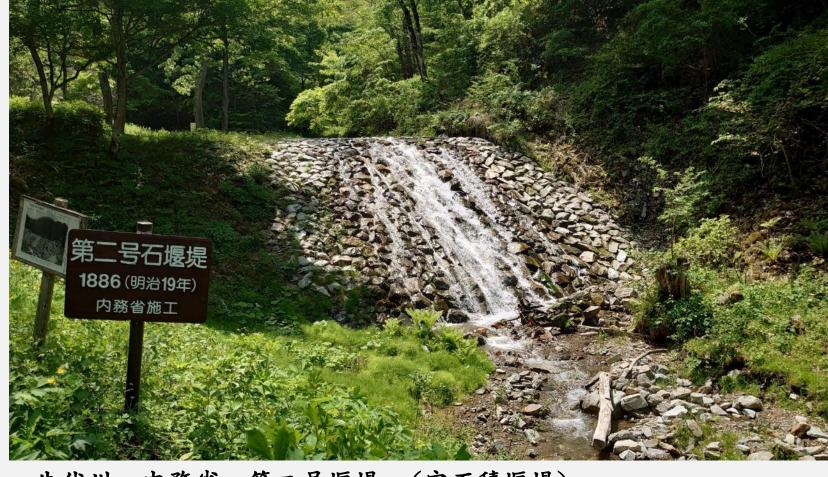
牛伏川 内務省 第二号堰堤 (空石積堰堤) 高さ6.5m 堤長24.5m以上
