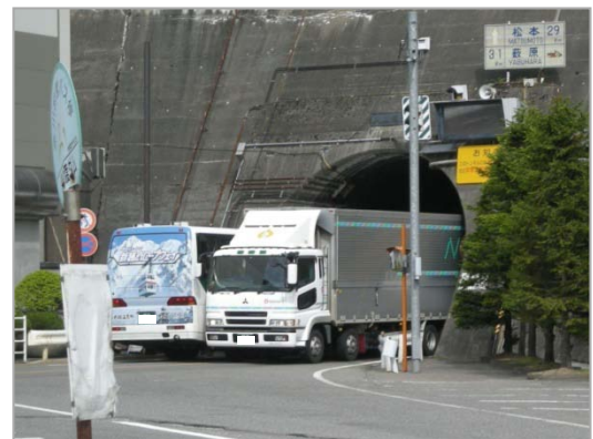
② 大型車のすれ違いが困難な 新入山トンネル（奈川渡ダム側坑口）
