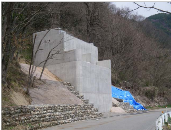
① 山清路防災 橋梁下部施工状況
