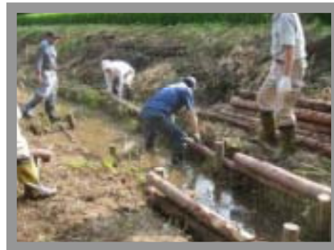
水路整備作業の様子(南信地域)
