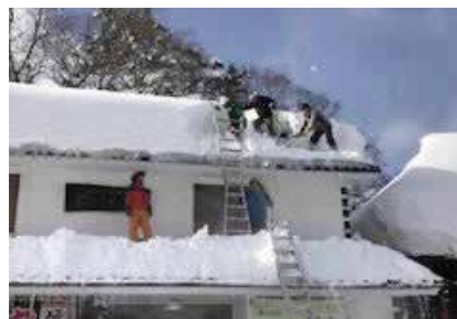
▲ 屋根の雪下ろし
