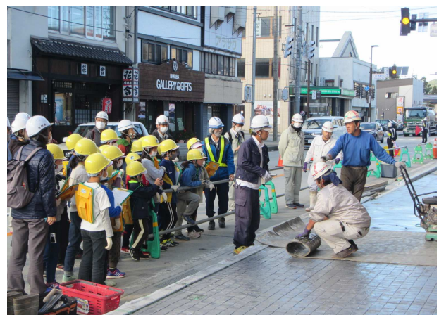
白馬駅前無電柱化工事の現場を見学する小学生(白馬村)
