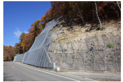
落石対策(大町市)
