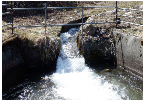
農業用水路の流量と落差を利用した小水力発電施設の設置予定地(白馬村)
