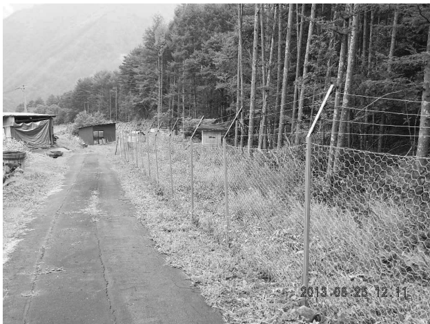
適正に管理されている侵入防止柵
