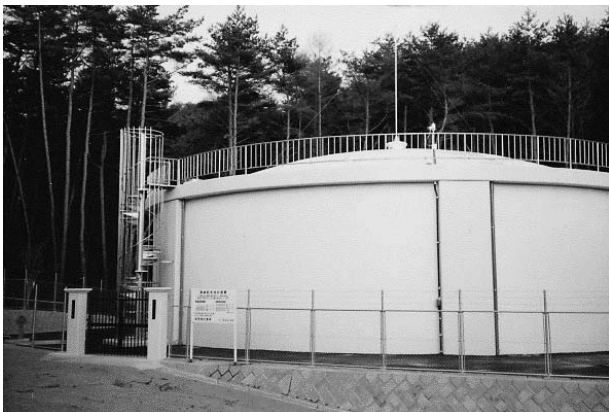
原峠配水池 容量 2,300m 3
