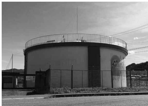
横出ヶ崎配水池
