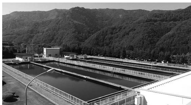
普段は静かな本山浄水場
