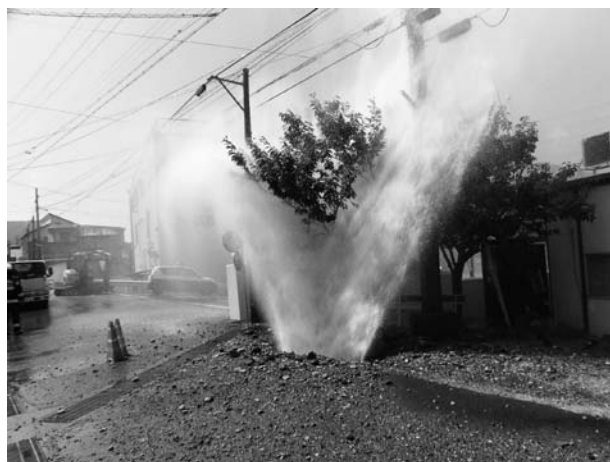
消火栓破損事故
