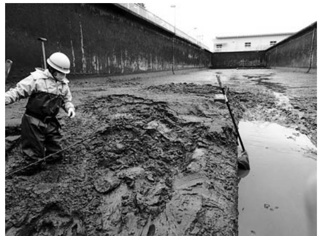
令和2年7月豪雨後 沈殿池清掃
