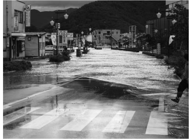
2019年10月13日 浸水の状況 千曲市杭瀬下
