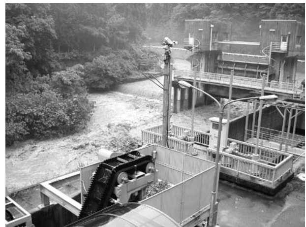
令和3年8月の大雨（片平取水場）
