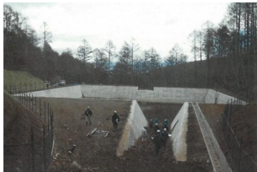
④ 森林地域の縮小区域(防災施設)
