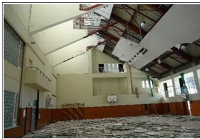
H23. 3月 北部地震 体育館の天井落下
