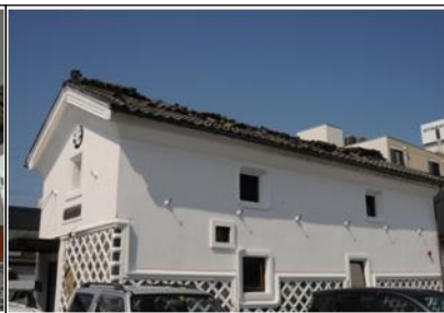
H23. 6月 中部地震 屋根瓦等の破損
