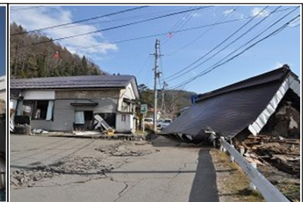
H26. 11月 神城断層地震 民家等の倒壊
