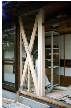
耐震改修(住宅)
