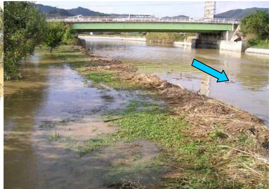
千曲川の水位が上昇すると、浅川への逆流を防ぐために合流部の樋門(水門)が閉まるため、ポンプを作動させて千曲川へ汲み出すが、ポンプの能力を超える水は、浅川の堤防を越え、宅地や田畑へ溢れる「内水はんらん」が発生する。このため、浅川の治水基準点位置では水位や流量を観測することは不可能である。
