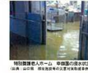
特別養護老人ホーム 等閑館の浸水状況 出典: 山形県 福祉施設等の災害対策調査報告書
