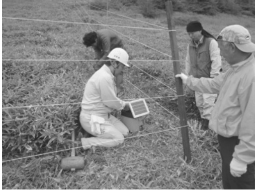
美ヶ原高原での侵入防止柵（電気柵）設置・ササ刈り
