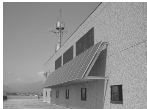
太陽光発電施設（松本合同庁舎）
