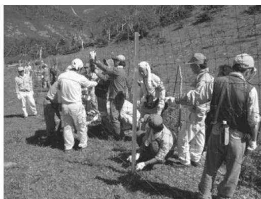
侵入防止柵（金柵）
