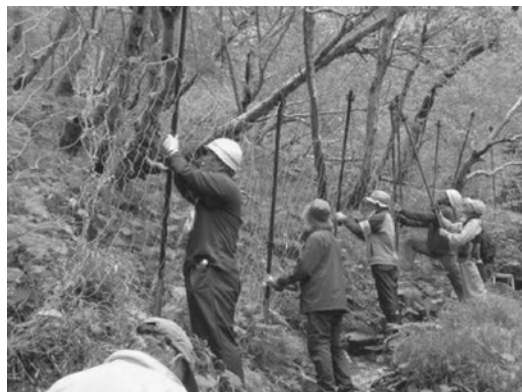
侵入防止柵（防護ネット）設置
