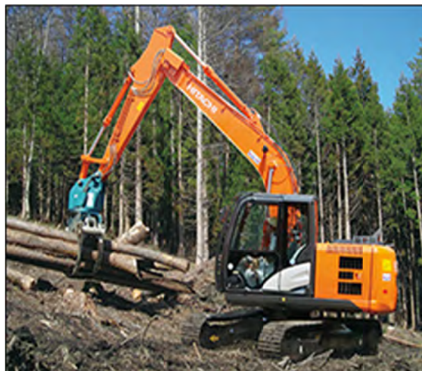
写真 1-6-5 伐採工事参考写真
