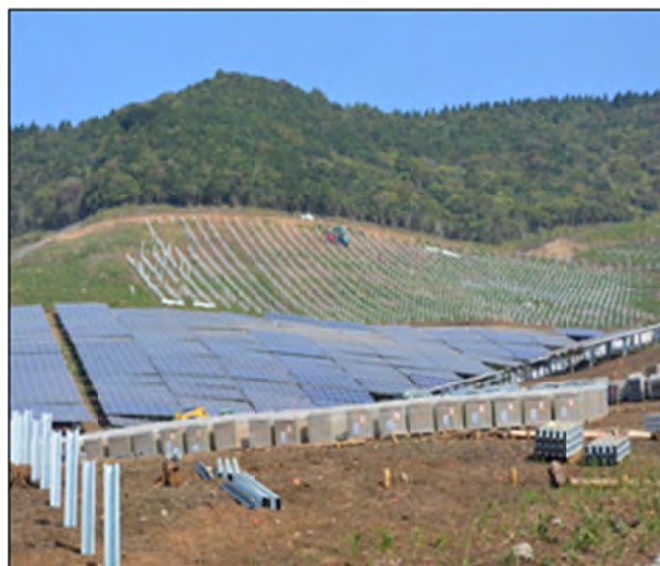
写真 1-6-1 林地設置事例
