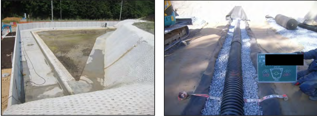
写真 1-6-4 防災工事参考写真（左：調整池設置工事、右：暗渠排水管敷設工事）
