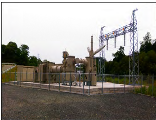
写真 1-6-3 送変電設備及び門型鉄構（イメージ）
