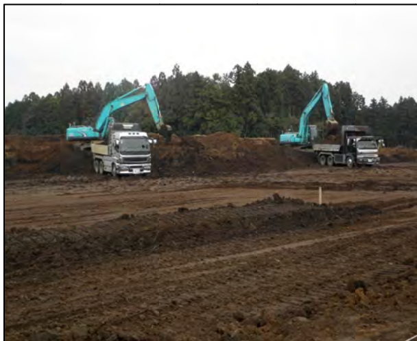
写真 1-6-6 造成工事参考写真
